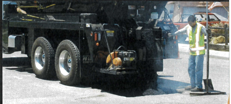
Add asphalt mix.
